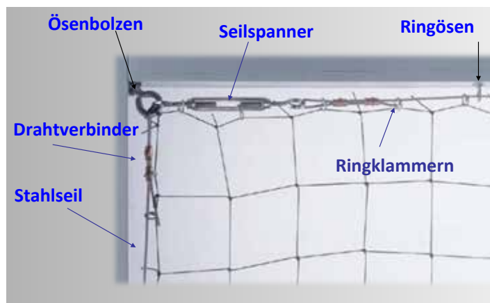
Installation einer Vernetzung. Abbildung: Volker Skor
