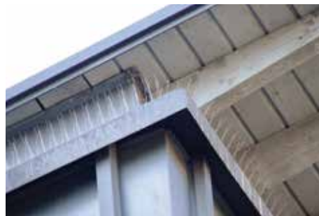
Spikes verhindern hier, dass sich Vögel auf dem Sims niederlassen. Foto: Volker Skor
